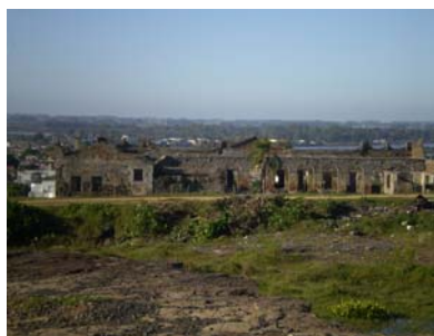
FIGURA 8 - VISTA DAS RUÍNAS DA ENFERMARIA MILITAR/ JAGUARÃO
