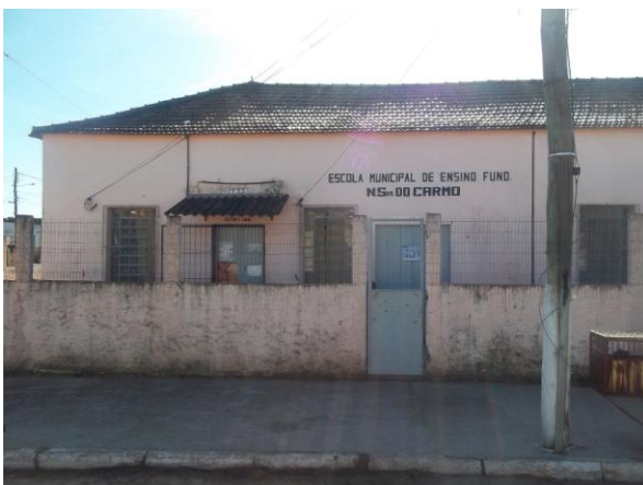
Figura 10 – Frente da E.M.E.F. Nossa Sr a do Carmo
