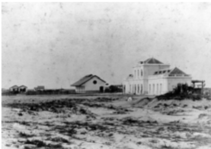
Foto 1 – construção do prédio, ano 1848 Fonte: Waderley Duck
