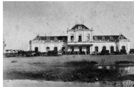
Foto 2 – Estação Férrea em atividade Fonte: Waderley Duck
