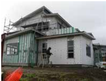
Figura 2: Sistema construtivo modular Steel framing.
